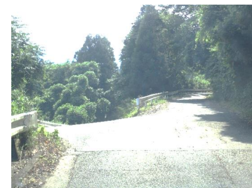
⑧道幅の狭い道路・交差点
