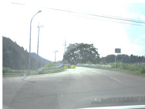
②急な曲がり角（工事中）
